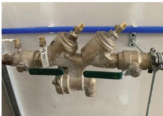
*Ejemplo de un sistema de prevención de reflujo de agua que puede ser utilizado en una piscina o sistema de calefacción a base de agua.*
